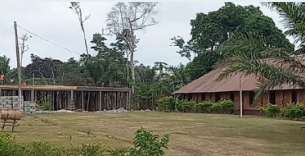
Klaslokaal en slaapzaal met het gebouw in aanbouw op de achtergrond
