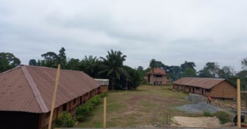
Een totaalbeeld van het seminarie met een stukje van het terrein van het nieuwe gebouw in aanbouw
